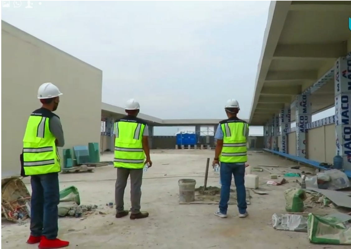
Pembangunan Kantin Sultan Untirta di Roof Top Untirta Sindangsari.
