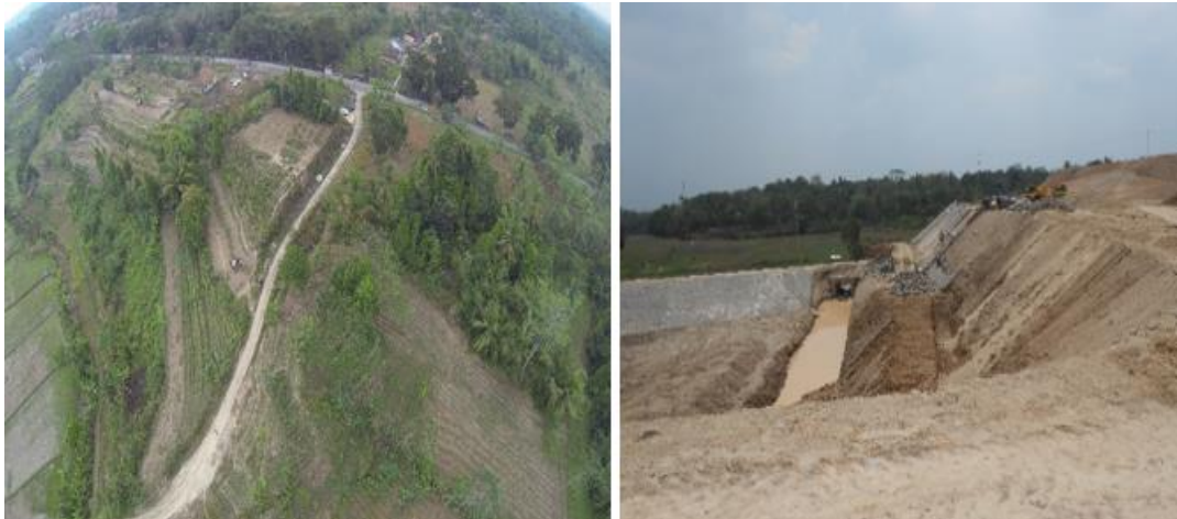
Gambar 7.6. Cut dan Fill Lahan Kampus Baru Sindangsari
