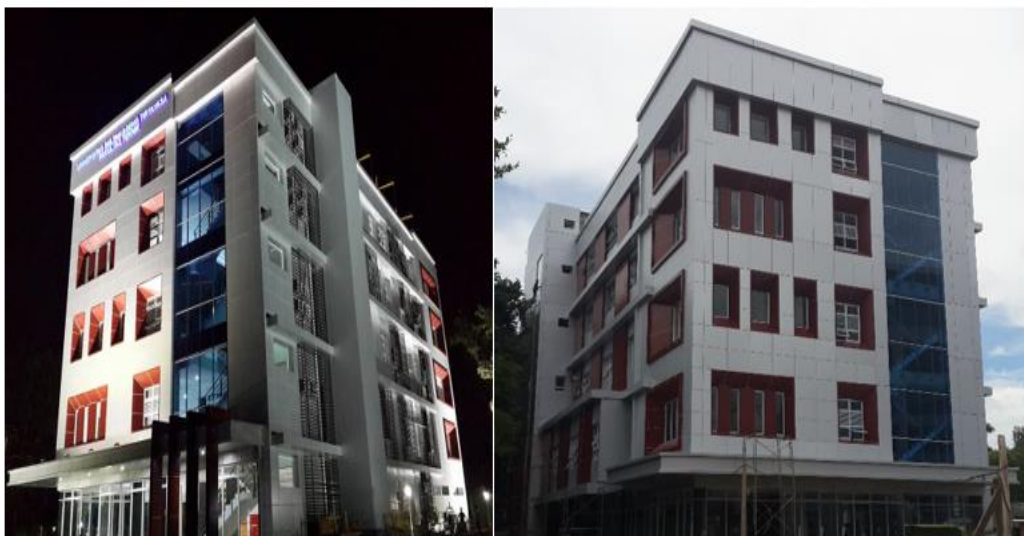
Gambar 7.4. Gedung Dekanat Fakultas Teknik Untirta
